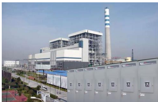
泰州电厂 7 台 6kV 软起动器
