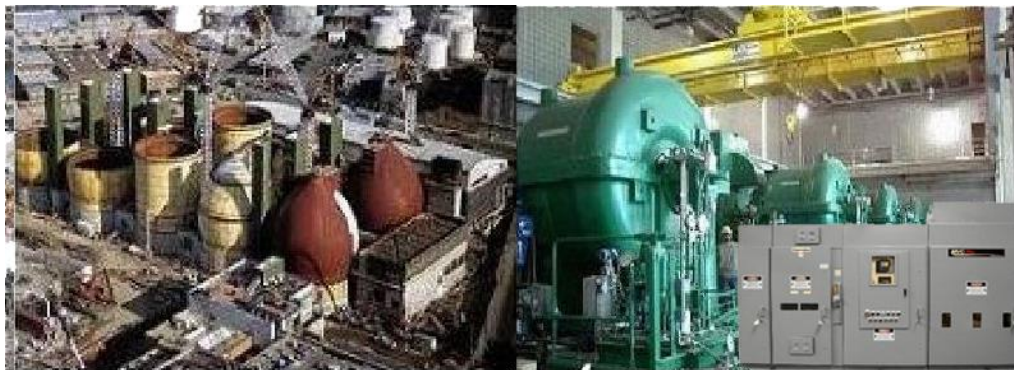
纽约供水项目 13.8kV 软起动器
